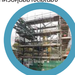
งานติดตั้งหน่วยบำบัดน้ำทิ้งด้วยโอโซน (Advanced Oxidation Process: AOPs)
