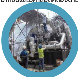
งานติดตั้งระบบทำความเย็น (Refrigeration System)
